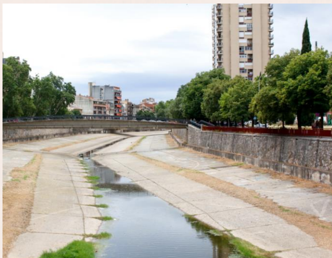
Llera del riu Onyar al seu pas per Girona, canalitzada i pavimentada
