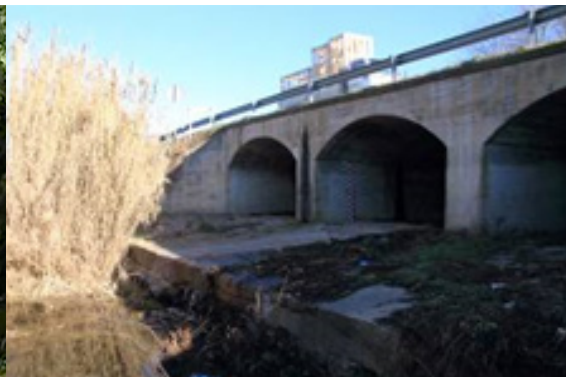
Carretera C-65 (Bugantó)
